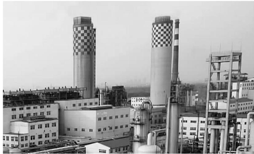
原本光秃秃的尿素造粒塔顶,心连心把它改造成了节能“皇冠”,通过对尿素造粒塔粉尘的回收,一条40万吨尿素的生产线一年就可产生经济效益100多万元。
