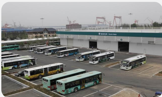
1 北京奥运电动汽车充换电站
