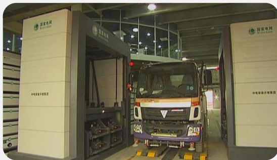
5 北京高安屯电动汽车充换电站
