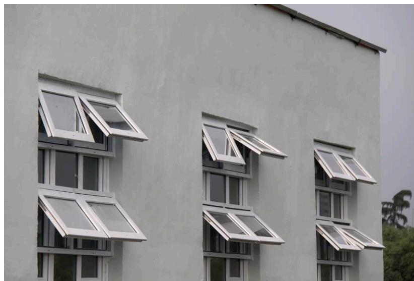
图 2.4 气候适应性南向窗（自拍）
