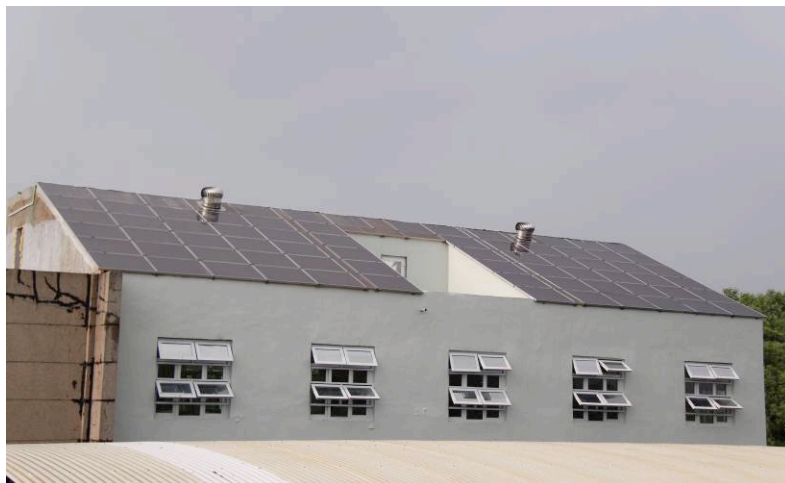
图 2.3 动态空气墙和屋顶太阳能电池的无动力风机出风口（自拍）
