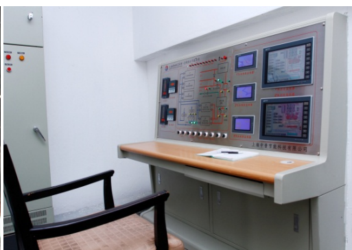
图4-6 改造后空调热水节能系统监控台
