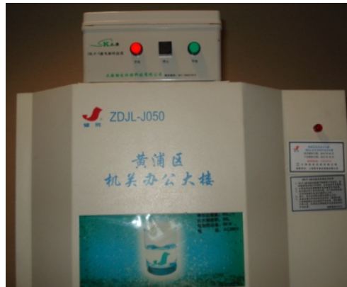
图 4-9 改造后的净水电加热饮水机运行情况
