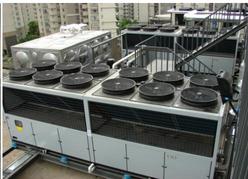
图 4-4 改造后节能冷热源回收机组
