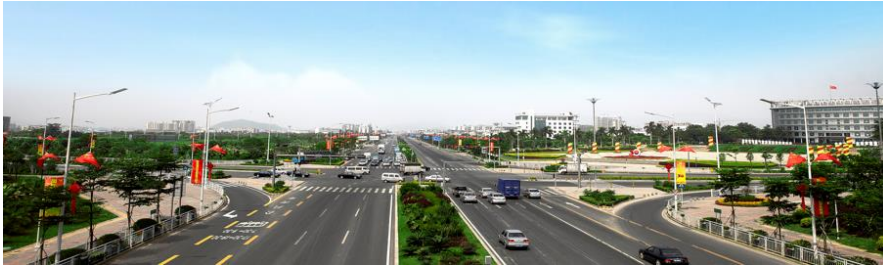
图 5-39 光明大道（LED 节能路灯、透水地面、光伏候车亭、再生沥青的绿色道路）
