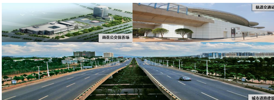
图 5-43 呈贡新区基础设施建成图
