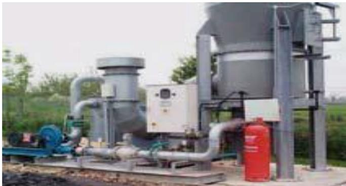
图8 热力氧化焚烧系统 (TO, Thermal Oxidizer) <sup>27</sup>
