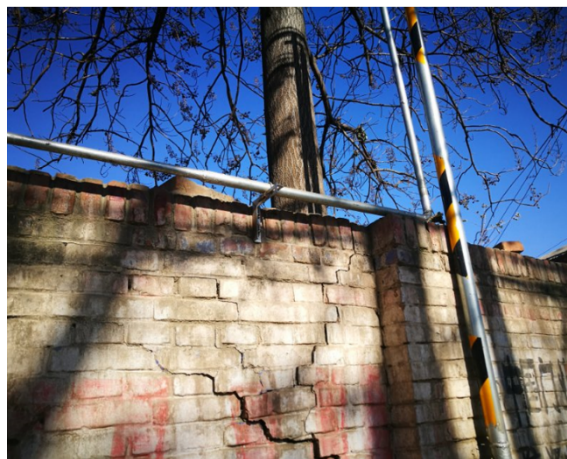
图3.17 管道支撑在危墙上（重大隐患）
