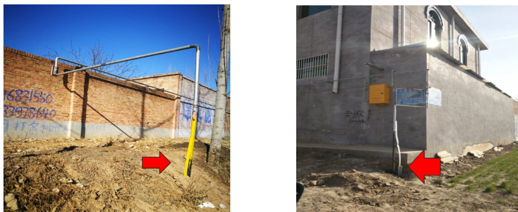
图3.16 引入口与建筑物距离大，未加任何保护措施（重大隐患）
