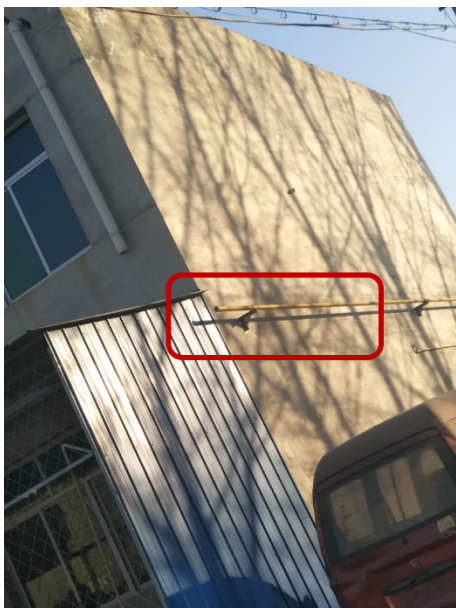
图3.28 末端盲肠太长，有隐患（中等隐患）
