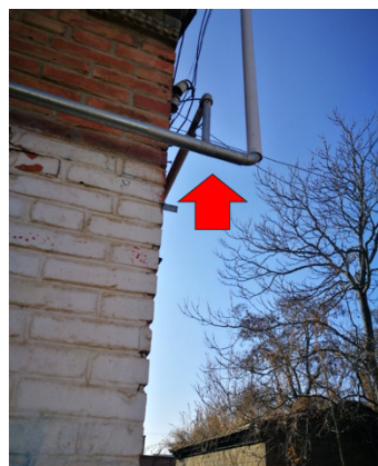
图3.23 燃气管线与电线、电力设施距离不符合要求，且未进行保护处理（中等隐患）
