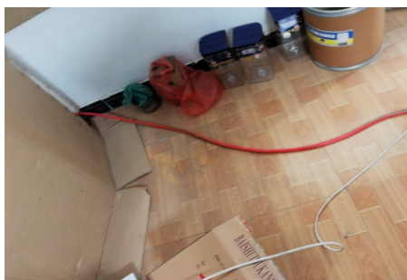
图3.30 胶管室内敷设过长及燃具随意放置（中等隐患）
