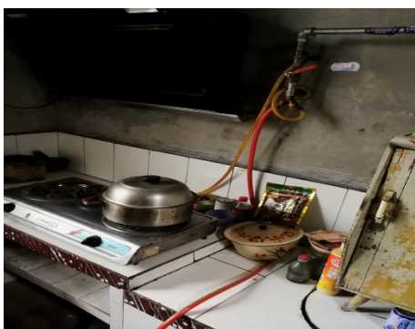
图3.30 胶管室内敷设过长及燃具随意放置（中等隐患）
