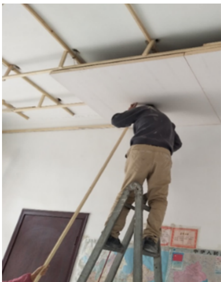
图 10 经济型吊顶和外墙内保温
