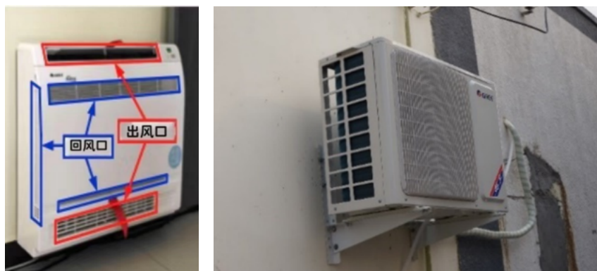
图 16 空气源热泵热气机的室内机和室外机
