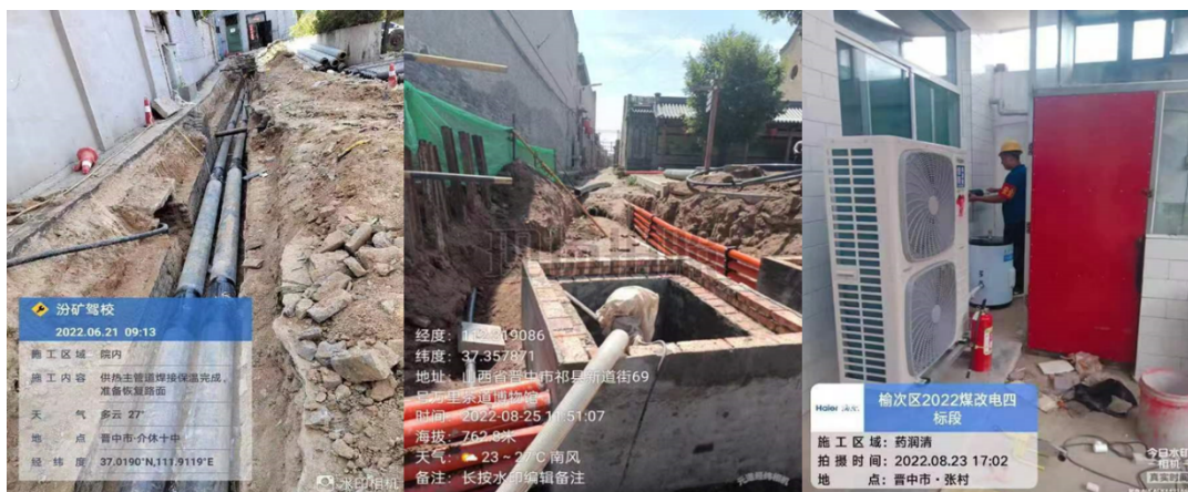
图 2-2 中部城市群散煤清零工程施工现场图
