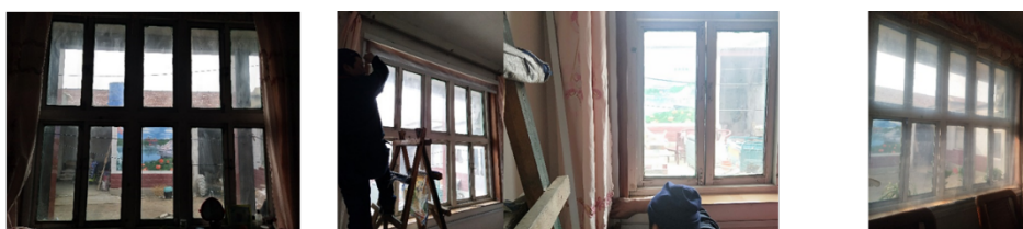
窗框清理 → 上卷膜框固定 → 边框固定 → 膜帘卷拉调整
