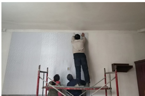
图 4-5 外墙内保温技术施工
