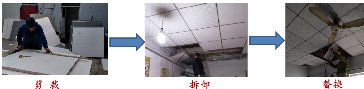
图 4-3 已有吊顶更换保温材料流程
