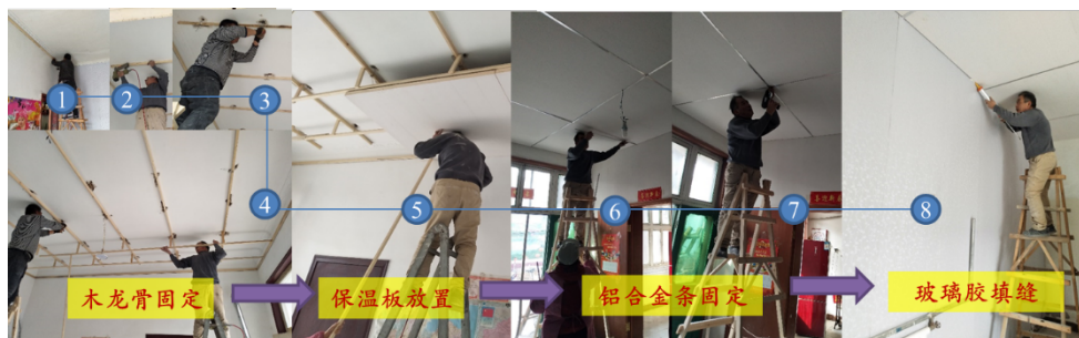
图 4-4 新增自保温吊顶施工流程
