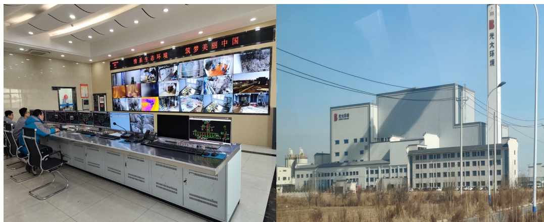
阳信光大环保垃圾焚烧发电项目
