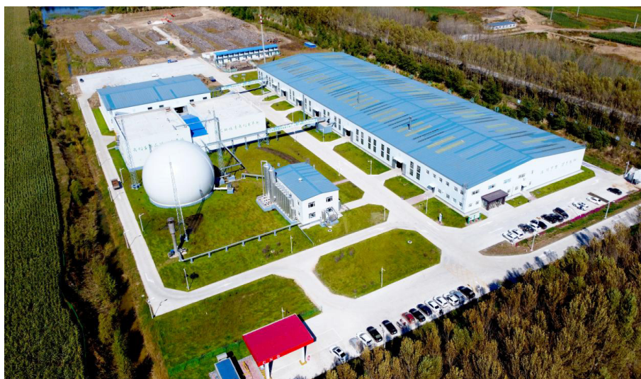
博能生态环保林甸县四合乡生物天然气项目
