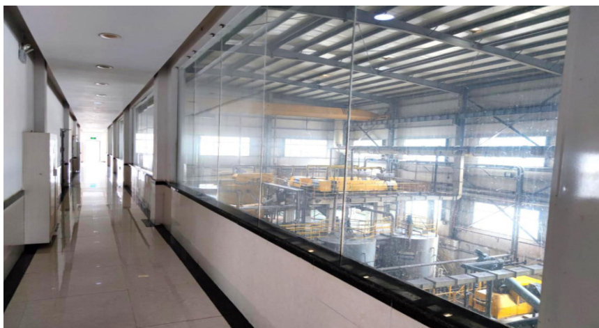
餐厨垃圾预处理车间
