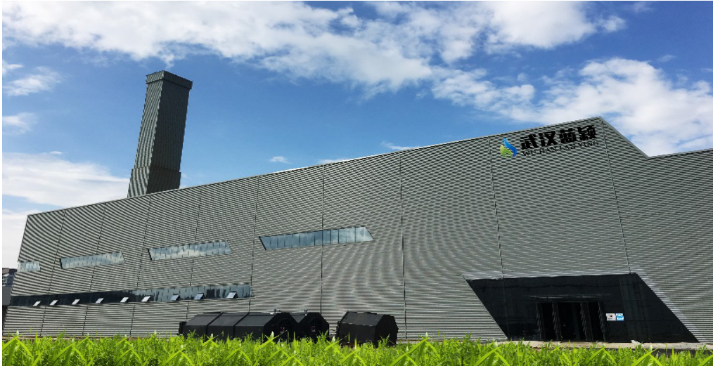
项目锅炉厂房
