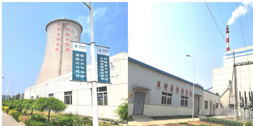
国能吴桥生物质发电有限公司热电联产项目
