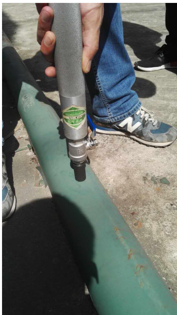
图 13 演示空压机管道带压打孔测试
