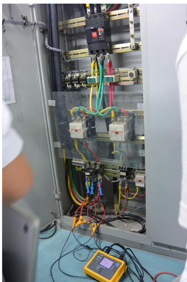
图 12 电机系统电力输入端测试
