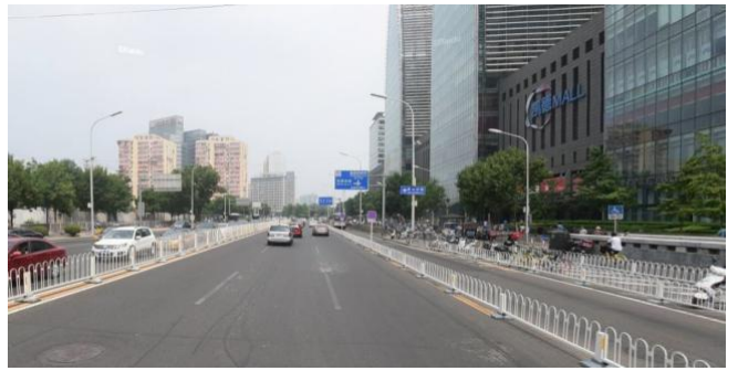
图 5-34 高梁桥路 (报告调研拍摄)
