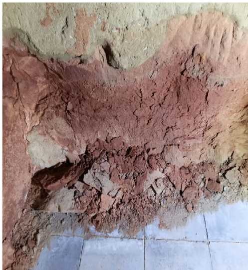
图 5-3 2022 年 8 月, 受阴雨天气影响, 由于岩体内 水的长期侵蚀, 金塔寺东窟西北角窟壁下部 岩体剥落, 严重影响洞窟立壁的稳定性的照片
