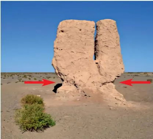
图 5-4 长时间缓慢的风化剥蚀造成严重的损毁（来源：王心源摄）
