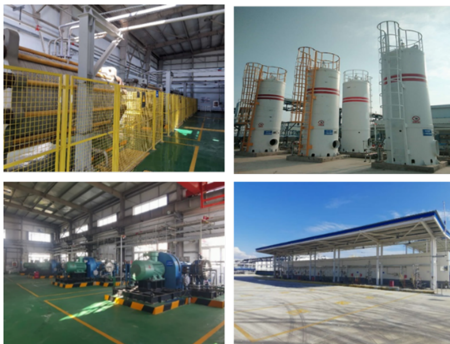
图 3 海珀尔制氢一期 (10MW)
