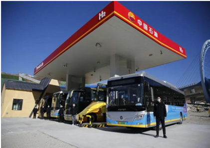
中石油太子城服务区加氢站
