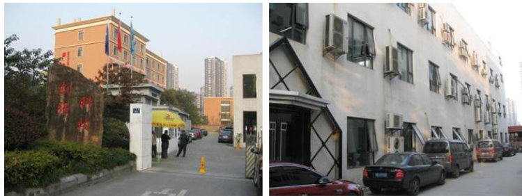
图2-28 杭州剑强科技厂房改造
