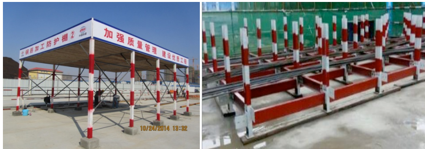
图 3-17 工具式钢筋加工棚、堆放场
