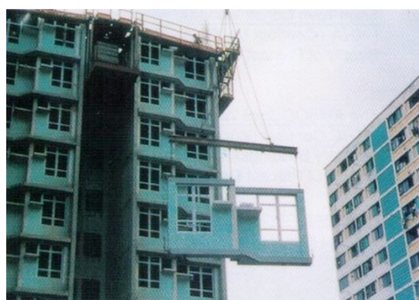
(c) 外墙安装 (d) 楼梯安装
