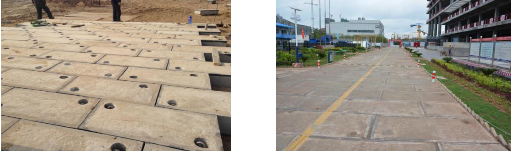
图 3-12 可周转预制砼路面
