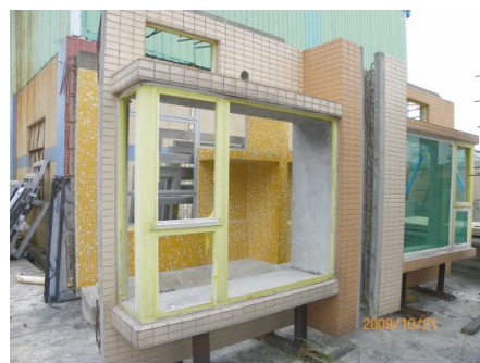
(a) 清水混凝土墙面效果 (b) 外墙一次成型
