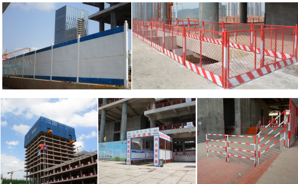
图 3-15 工具式外墙围挡、临边防护
