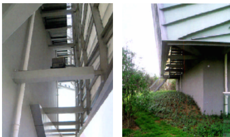
图 2-27 开放式玻璃幕墙内外部
