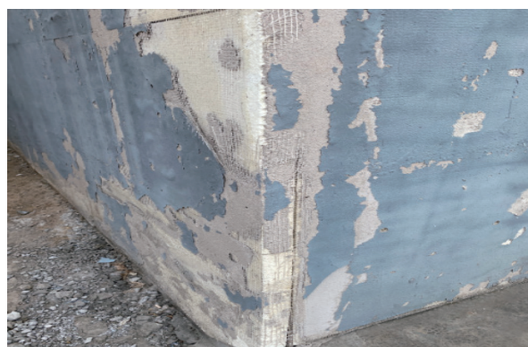
图 11 保温板外侧保护层脱皮开裂
