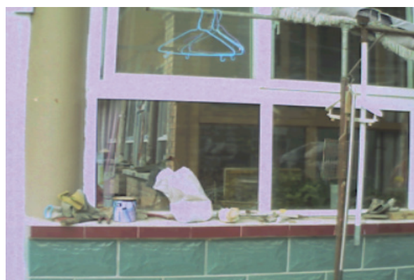
图 12 窗墙间存在的缝隙
