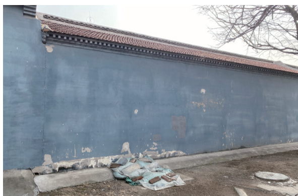
图 11 保温板外侧保护层脱皮开裂
