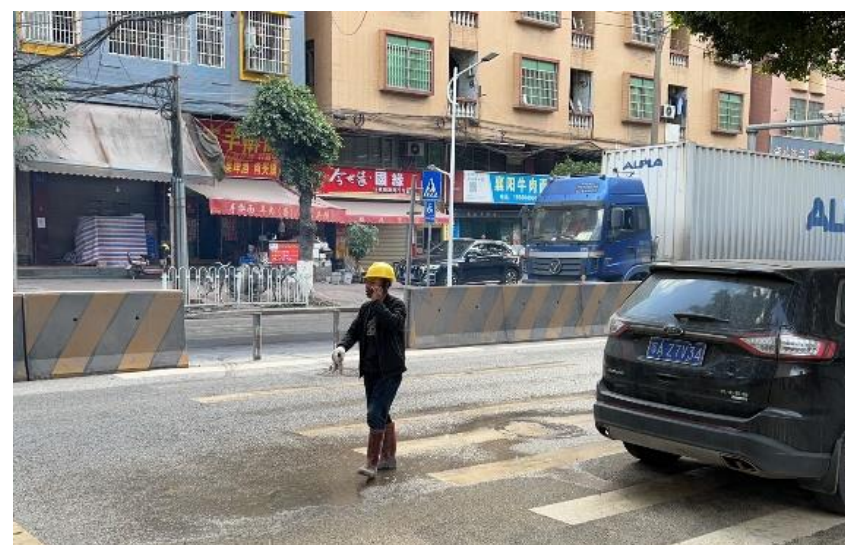
信华路沿路多处路中过街安全岛宽度较窄，无法容纳行人和非机动车短暂停留。
