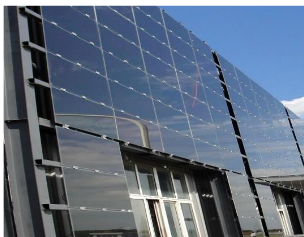
图 2.4 建筑立面光伏系统
