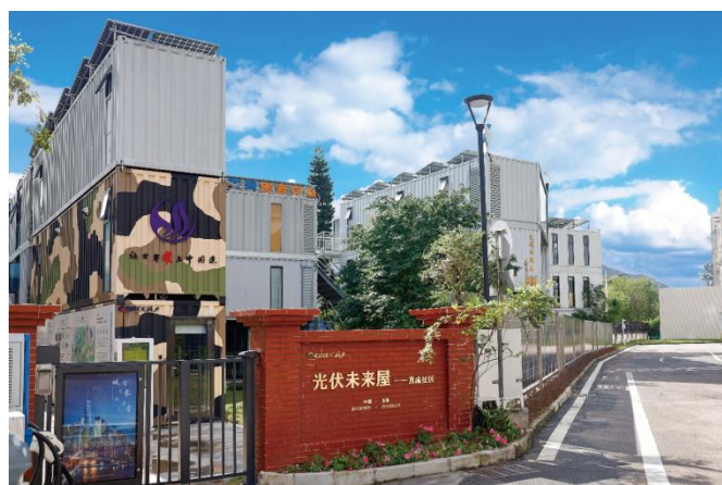
图 15 光伏未来屋V直流社区项目
