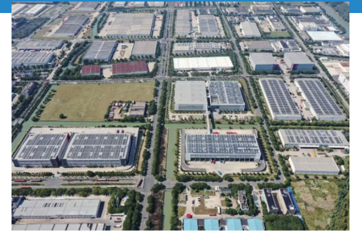
图示：苏州工业园区屋顶光伏
