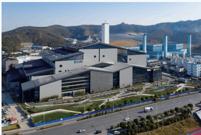
图示：七子山垃圾焚烧发电厂
