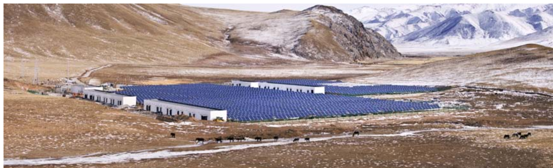
图 3-6 玉树 2MW 光伏电站
