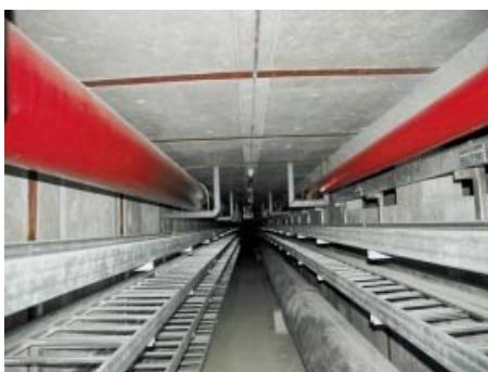
图 4-17 光明新区共同管沟建设实景
