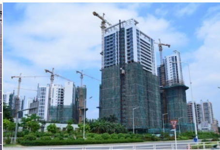
图 4-19 光明办事处保障性住房项目
