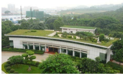
图 4-21 新区管委会附楼的屋顶绿化现状
