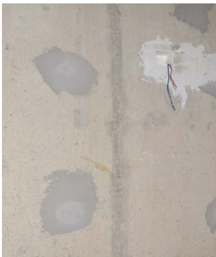
图 24：对穿螺栓孔洞密封
