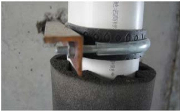
图 30：固定 U 型卡垫隔音垫
