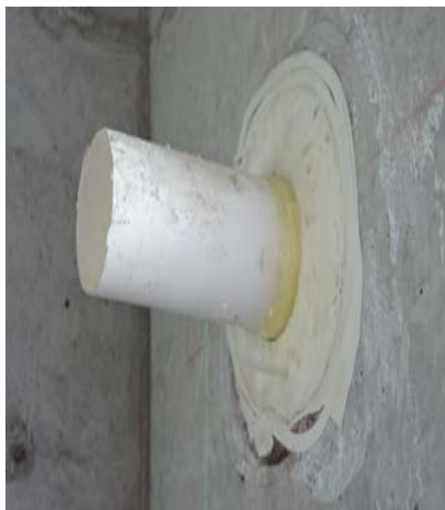
图 18：穿墙套管保温
