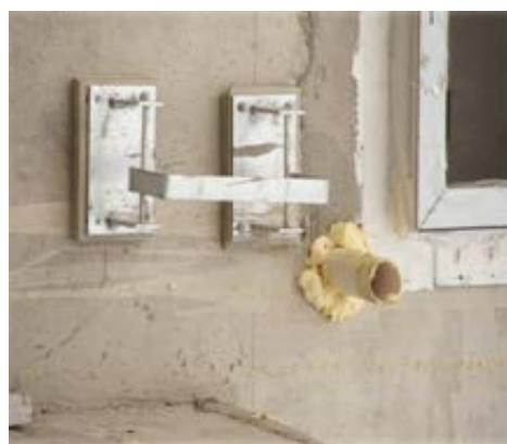
图 21：雨落管支架
