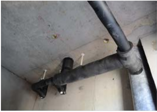
图 29：室内排水管保温隔音
