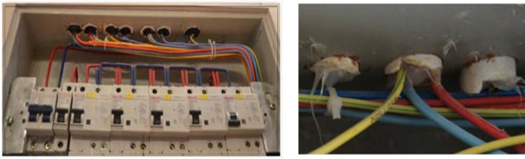
图 27：集线盒及电线套管密封
