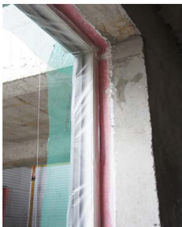
图 12: 外窗的安装
