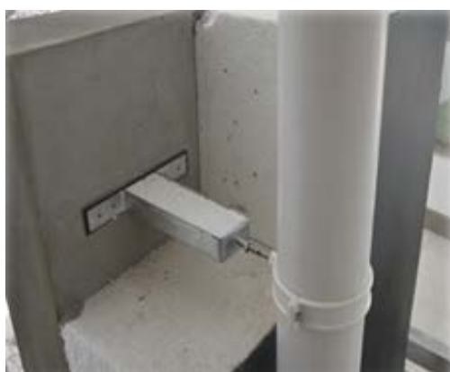
图 20：太阳能热水支架
