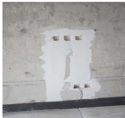
图 23：电线管路改造用石膏封堵缝隙
