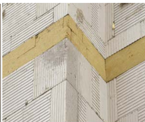
图 4：外墙保温及防火隔离带
