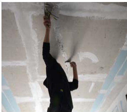
图 22：缝隙封堵
