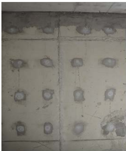
图 24：对穿螺栓孔洞密封
