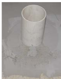
图 25：穿墙套管发泡后内外用网格布抗裂砂浆封堵
