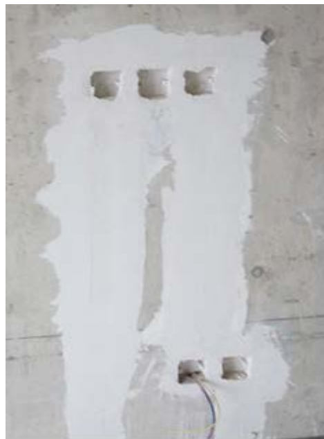
图 31：电器开关插座隔音
