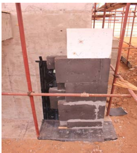
图 5：地下室外墙防水保温
