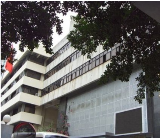
图 6.8 第二类政府办公建筑典型建筑
