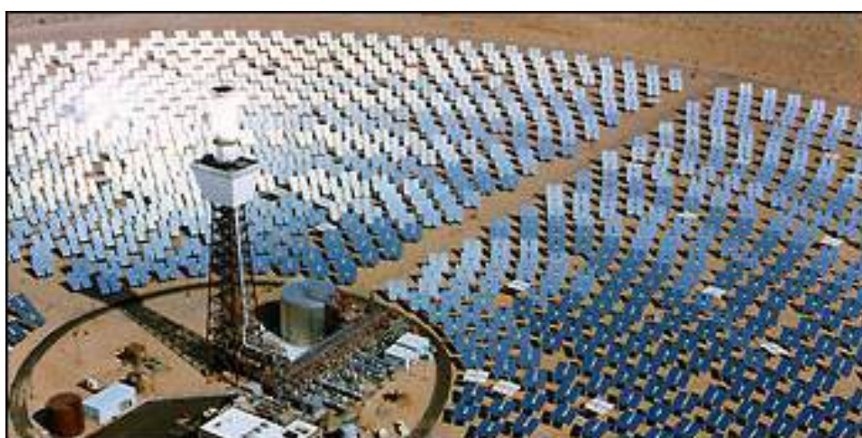
图 16 Solar Two 的接收塔和定日镜
