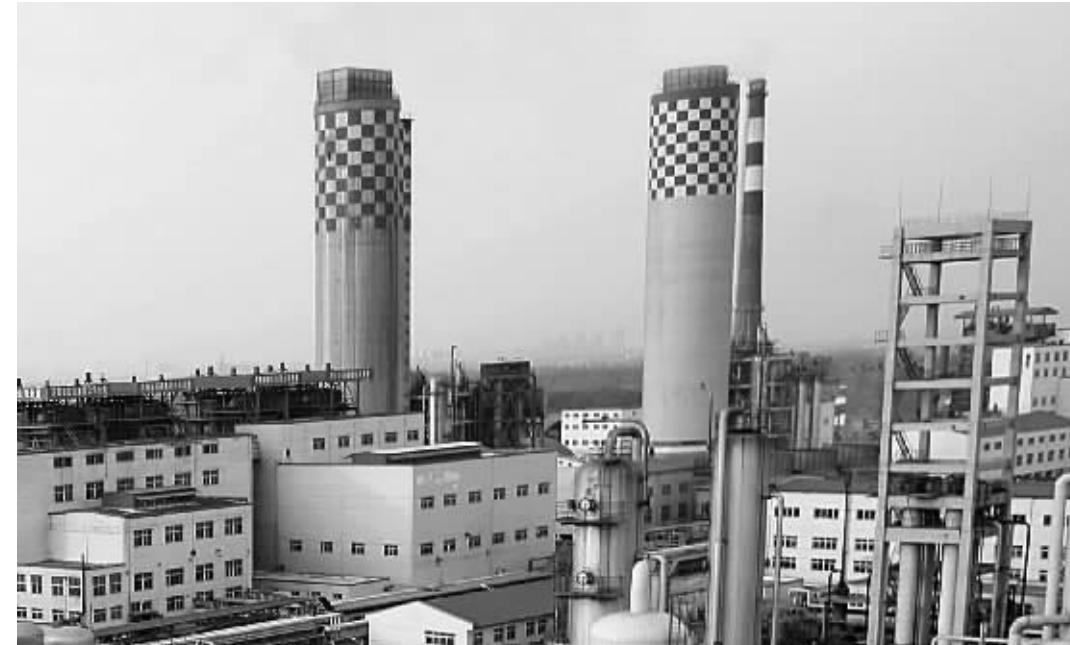
原本光秃秃的尿素造粒塔顶，心连心把它改造成了节能“皇冠”，通过对尿素造粒塔粉尘的回收，一条40万吨尿素的生产线一年就产生经济效益100多万元。
