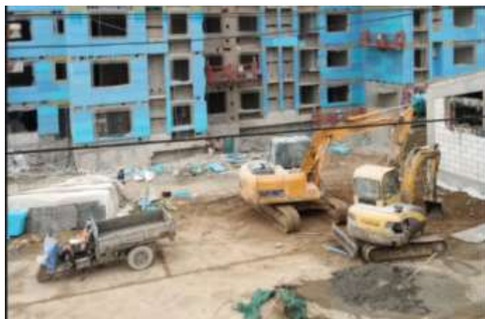
图11. 2016年10月7日，朝阳区一处使用柴油机械的建筑工地，现场未发现冒黑烟情况
